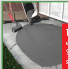
**TIPP:** Für große horizontale Flächen eignet sich das gießfähige MEM WATER STOP LIQUID besonders gut. So lassen sich z. B. Terrassen, Balkone, Flachdächer und Carports ganz leicht abdichten.
